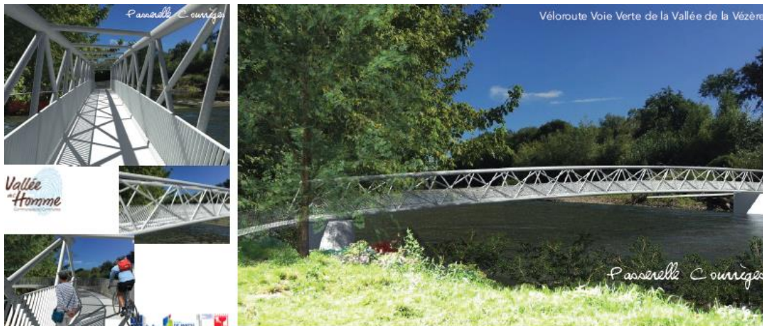
Passerelle des Courrèges (Source : dossier)
