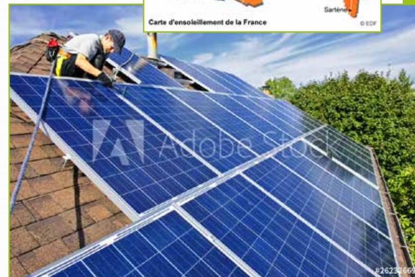
Pose de panneaux solaire en toiture, la Dordogne dispose d'un ensoleillement permettant à chaque particulier d'envisager cette solution.
